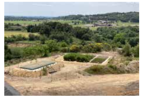
Essais sur site de végétalisation d'un technosol (substrat constitué à partir des matériaux du site)
