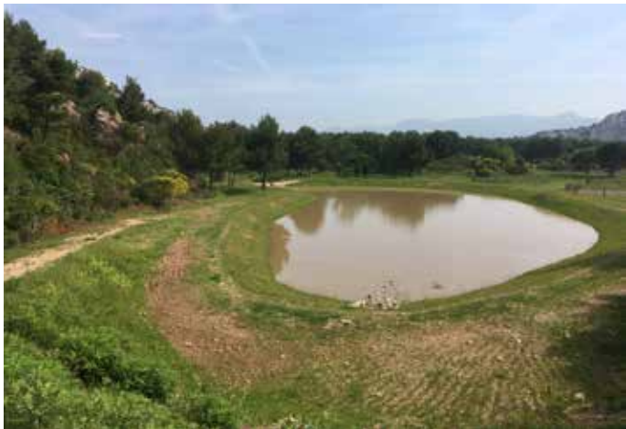
Intégration paysagère d'un bassin de rétention des eaux pluviales et de son chenal d'évacuation
