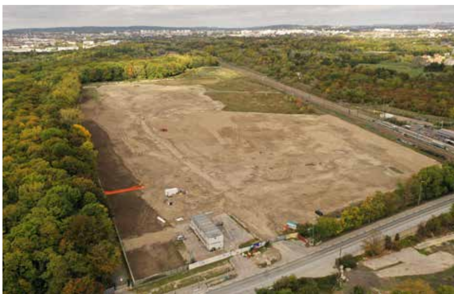
Figure 5. Vue du chantier après les travaux
