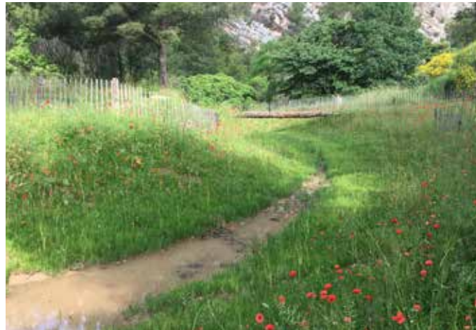
Intégration paysagère d'un bassin de rétention des eaux pluviales et de son chenal d'évacuation
