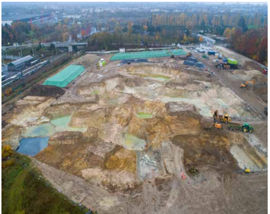
Figure 1. Vue du chantier pendant les travaux
