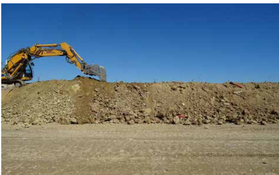
Opération de remblaiement par des matériaux de granulométrie variée, sans contrainte géotechnique majeure
