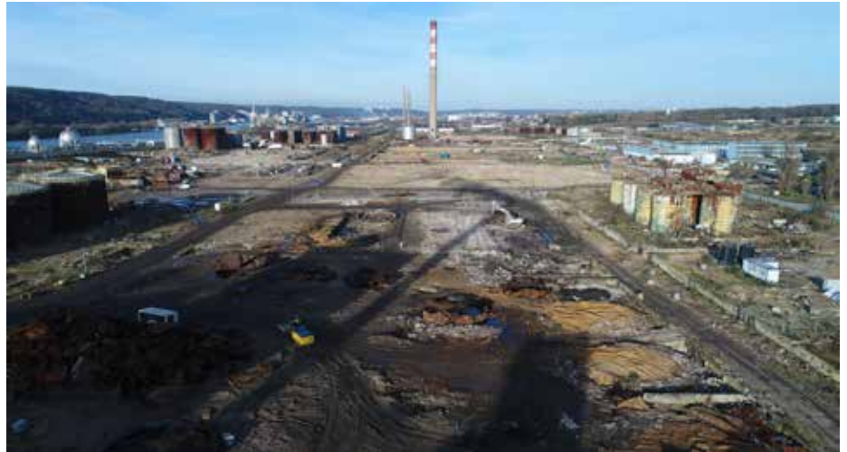
Site de l'ancienne raffinerie Pétroplus en cours de reconversion – Petit-Couronne, janvier 2020
