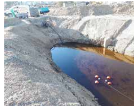
Pompage en fouille ouverte (Z17)
